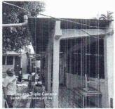
SE OBSERVA QUE LA ESTRUCTURA DE MADERA YA NO ES FUNCIONAL Y SE DEBE SUSTITUIR
