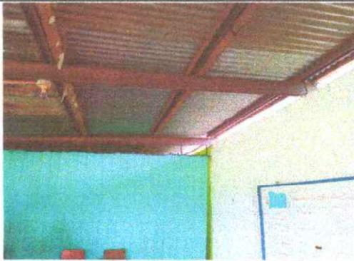
Foto 3: Sustitución de estructura. Se encuentra oxidadas y en mal estado.
