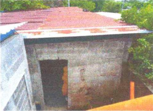
Foto 1: Sustitución de muro perimetral. Para agregarle un metro de altura.
