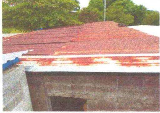
Foto 2: Sustitución de lámina. Por que ya se encuentra oxidada y deteriorada.
