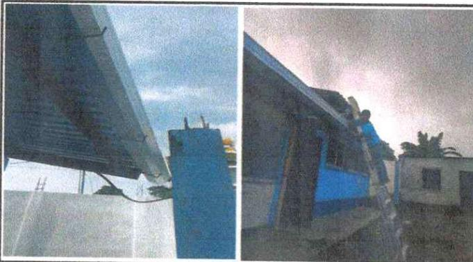
Foto 3: (1.3. Instalacion de canales para evitar goteras a los peatones.)
