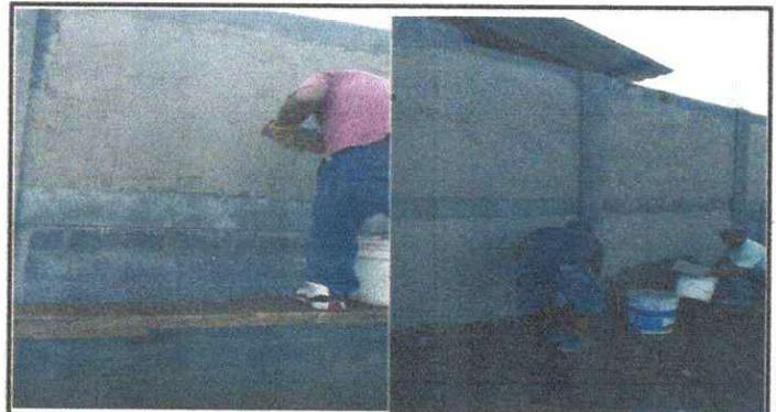
Foto 10: MÓDULO 4 (1.13. Repello en muro.)
