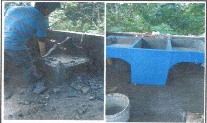
Foto 8: (1.9. Sustitución de pila de cemento con dos lavaderos.)
