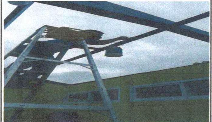
Foto 2: (1.2.Aplicación de pintura y mantenimiento en costaneras.)
