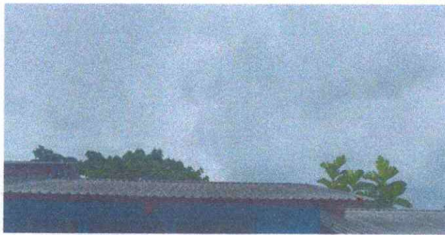
Foto 3: (1.3.Goteras que afectan al peaton.)
