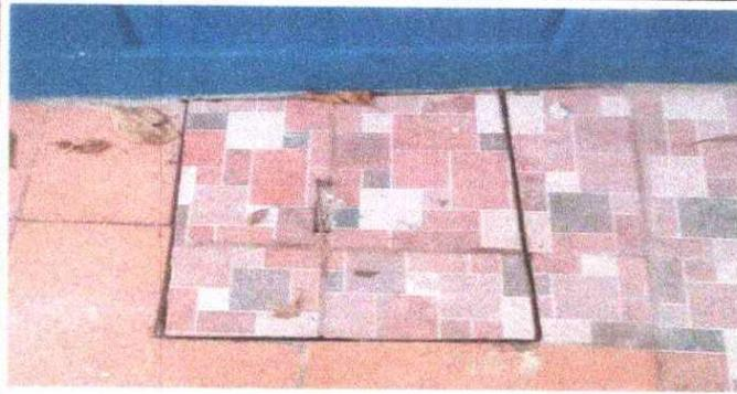
Foto 7: Reparación de tapaderas de caja: Se observa que no cuenta con tapadera.
