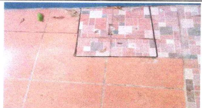
Foto 8: Reparación de piso de torta de concreto: Se observa con muchas grietas en toda la plancha.
