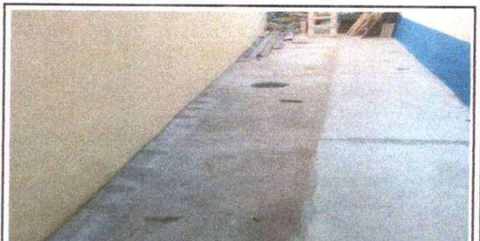
Foto 6: Reparación de planchas de concreto: Se observa en mal estado con partes quebradas.
