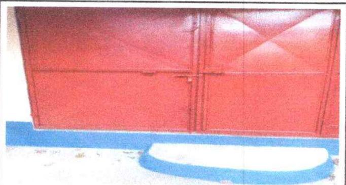
Foto 2: Sustitución de porton de malla por metal: Se observa que esta muy picado y oxidado.
