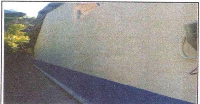
Foto 4: Repello de muro: Se observa que no cuenta con el repello.
