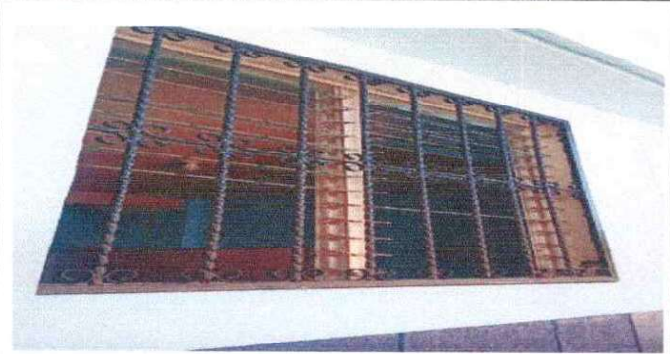
Foto 8: Los balcones estan con mucha corrosion
