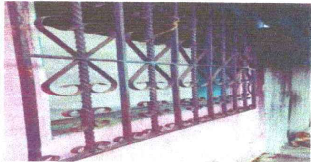
Foto 8: Los balcones estan con mucha corrosion
