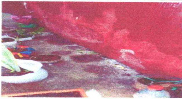
Foto 7: La pintura se esta levantando por la humedad
