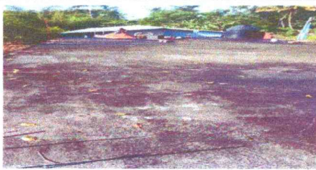
Foto 3: Trasmite humedad al interior
