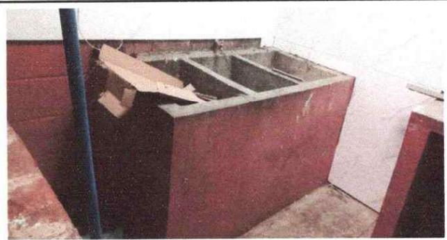
Foto 4: suministro de azulejo en pila , la pila acumula mucho cedimento no se puede hacer limpieza.
