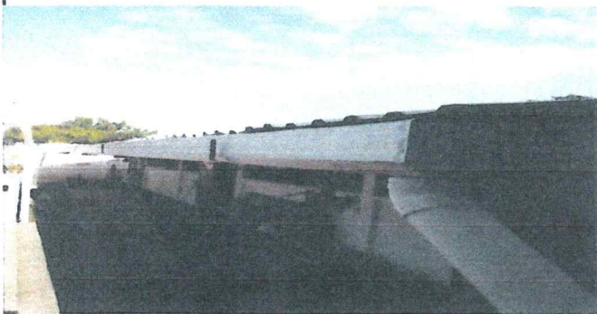
Foto 3: Suministro de canales y caída de agua
