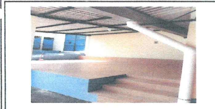
Foto 5: Suministro de estructura metalica y lamina troquelada
