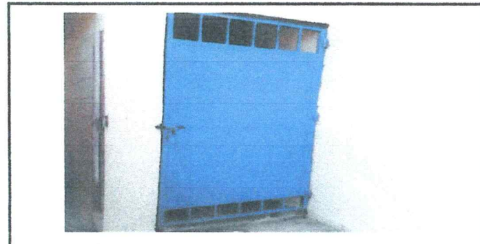
Foto 6: Sustitucion de puerta en servicio Sanitario
