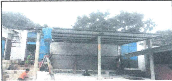
Foto 1: Sustitución de lámina troquelada
