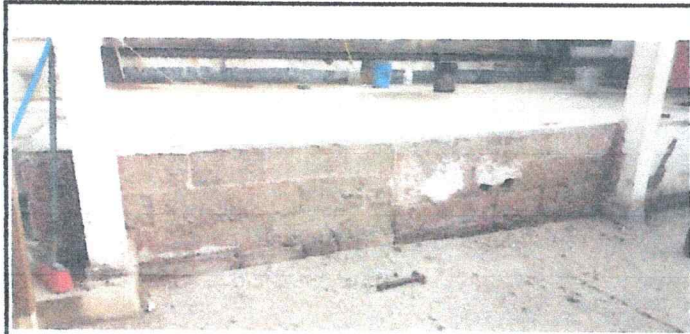
Foto 3: Suministro de piso cerámico
