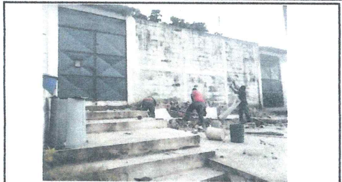
Foto 2: Reparación de muro perimetral
