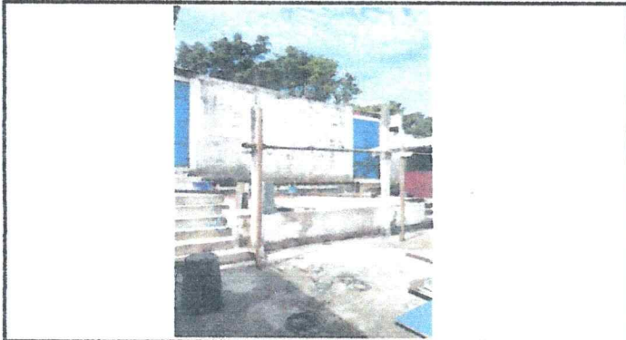
Foto 1: Sustrucción de estructura metálica y lámina
