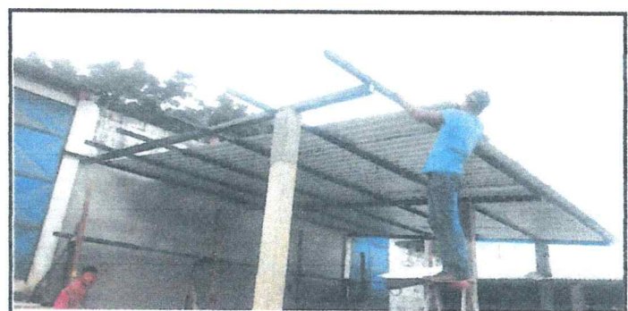
Foto 6: Sustrucción de estructura metálica y lámina
