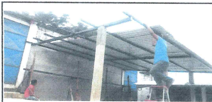
Foto 5: Sustrucción de estructura metálica y lámina
