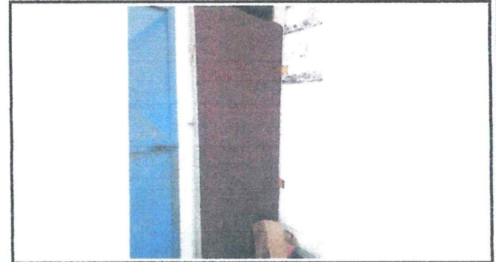
Foto 4: Sustitución de puerta en servicio sanitario
