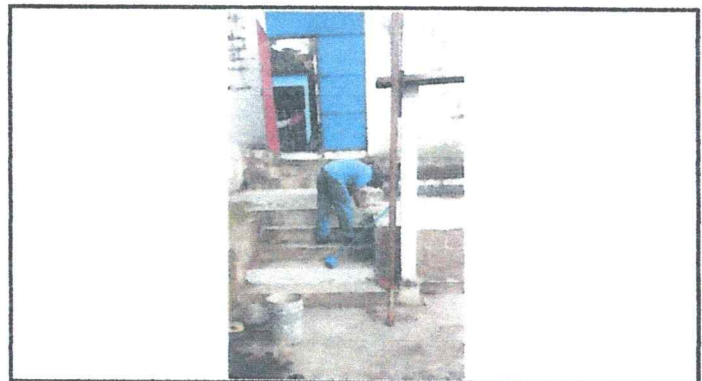
Foto 4: Pintura en muro perimetral
