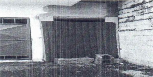
ES NECESARIO CAMBIAR LA PUERTA DE SERVICIO SANITARIO YA QUE SE OBSERVA QUE SOLO HAY UNA LAMINA PROVISIONAL PARA CUBRIR EL AREA
