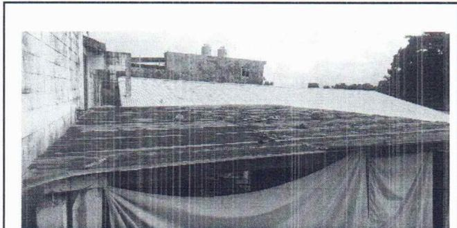
SE NECESITA SUSTITUIR LA LAMINA POR LAMINA TROQUELADA
