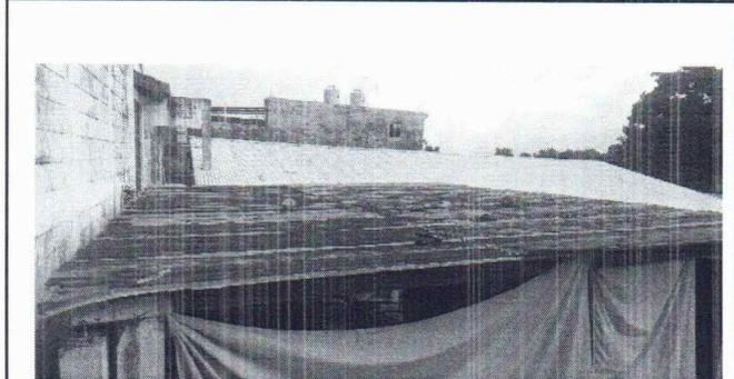
SE NECESITA EL CAMBIO DE LA ESTRUCTURA METALICA PARA SOPORTE DE LAMINA TROQUELADA
