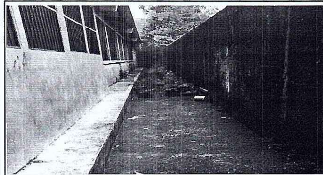
Foto 3: MURO PERIMETRAL Y MODULO DE AULAS
