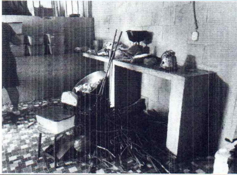
Foto 7: Se observa que la situación actual del área donde preparan los alimentos, no permite su correcta limpieza por el material del que está hecha, por lo que es necesario colocar azulejo.
