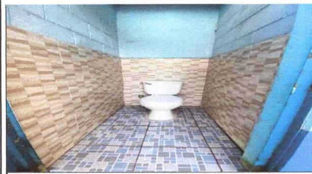
Foto 5: Instalación de piso antideslizante, sanitario y azulejo en los diferentes sanitarios.
