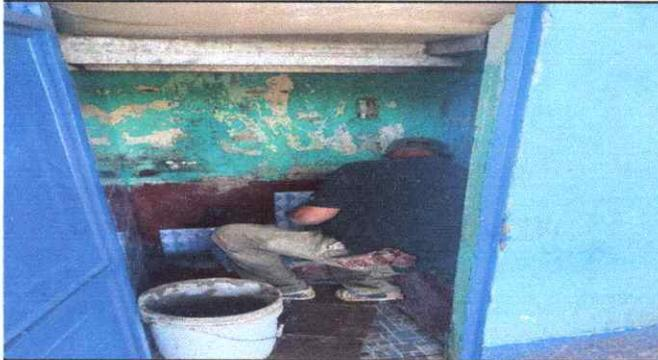
Foto 1: Se realiza el cambio de piso y colocación de azulejo en el área de migitorio.
