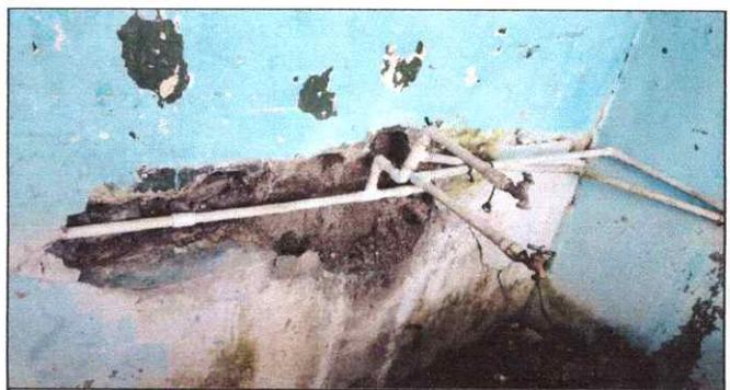
Foto 6: Cambio de tubería de agua principal de la escuela.
