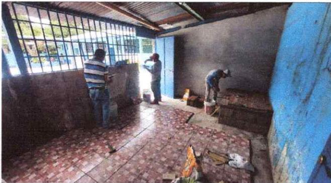
Foto 3: Colocación del piso cerámico en el área de cocina.
