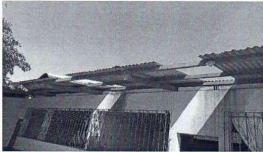
Foto 1: Se observa lamina de aulas en muy mal estado
