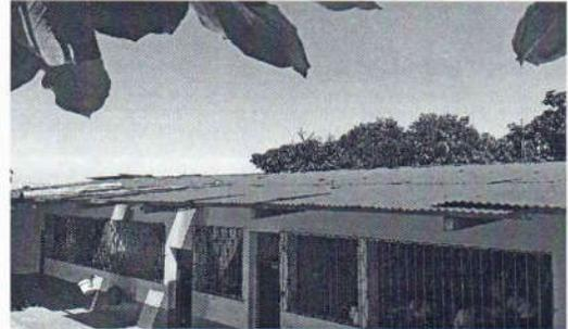
Foto 2: Se observa Laminas en muy mal estado
