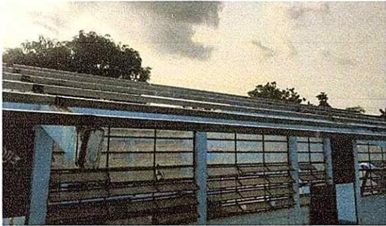
Foto 12 : se observa la sustitucion total de costaneras.
