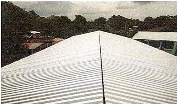
Foto 14: Se observa la instalación de lamina nueva en el modulo No.3.
