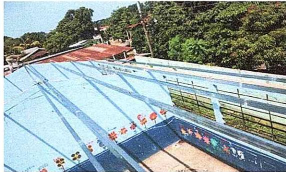
Foto 13: Se observa parte de arriba la sustitucion de costaneras.
