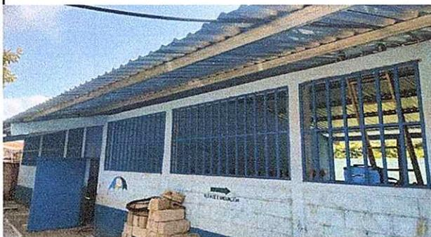
foto 16: Se puede observa costaneras,laminas,balcones totalmente remplazados y las puertas reparadas.
