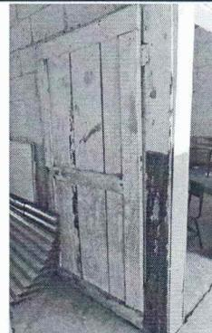
Foto 4: Se observa puerta de madera en mal estado, es necesario su sustitución
