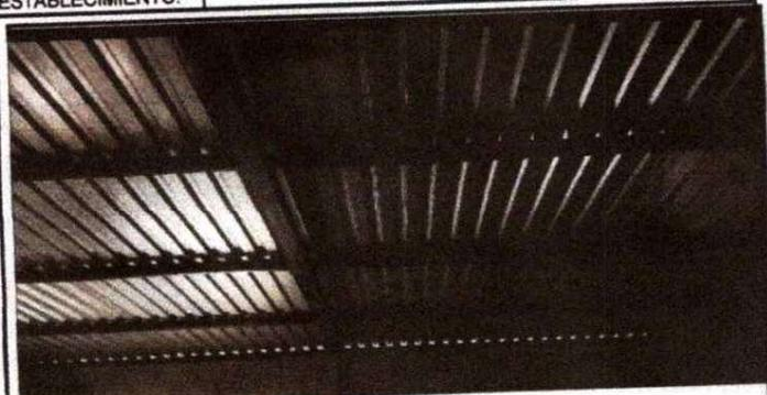
Foto 1: SE OBSERVA QUE LA LAMINA TROQUELADA CALIBRE 26 ALUZINC , SE COLOCO POR COMPLETO LOS TRABAJOS FUERON FINALIZADOS
