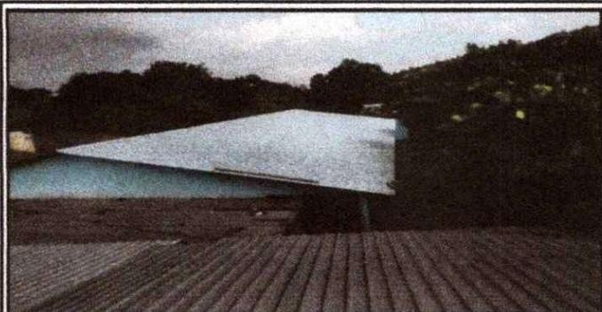
Foto 9: SE OBSERVA QUE LA LAMINA TROQUELADA CALIBRE 26 ALUZINC SE COMPLETARON LOS TRABAJOS.
