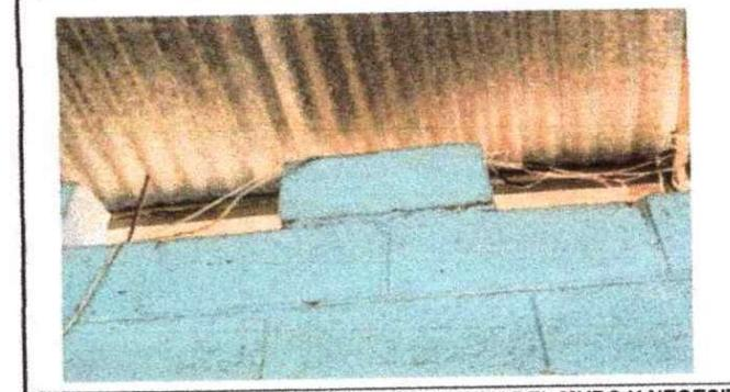
**FOTO 4 : SE OBSERVA QUE FALTA ELEVACION DEL MURO Y NECESITA COLOCACIÓN DE DOS ILADAS DE BLOCK, PORQUE HACE MUCHO CALOR EN EL AULA.**
