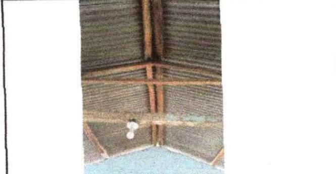
**Foto 2: SE OBSERVA QUE LA ESTRUCTURA DE MADERA SE ENCUENTRAN EN MAL ESTADO , ES IMPORTANTE EL CAMBIO POR METAL CARÁCTER URGENTE.**
