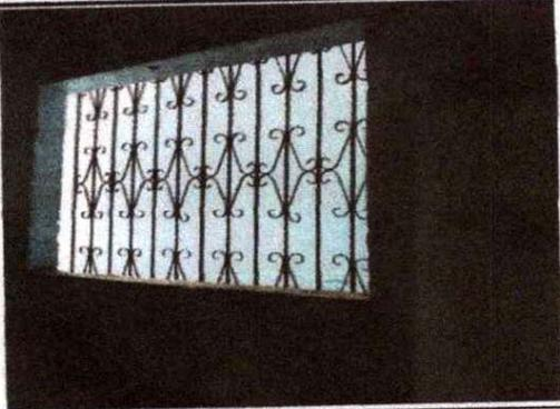
**Foto 7: SE OBSERVA QUE LOS BALCONES DE METAL ENSTAN EN MAL ESTADO POR LO QUE NECESITA EL MANTENIMIENTO URGENTE.**
