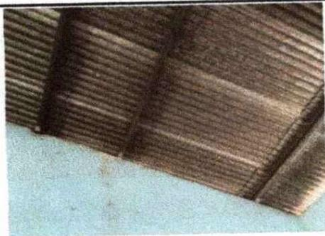
**Foto 9: SE OBSERVA QUE LA LAMINA EXISTENTE ESTA DETERIORADO POR LO QUE URGE LA SUSTITUCION POR LAMINA TROQUELADA.**
