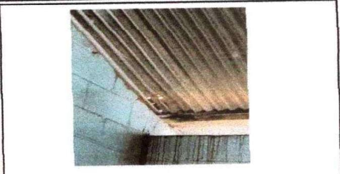
**Foto 1: SE OBSERVA QUE LA LAMINA EXISTENTE ESTA DETERIORADO POR LO QUE URGE LA SUSTITUCION POR LAMINA TROQUELADA.**
