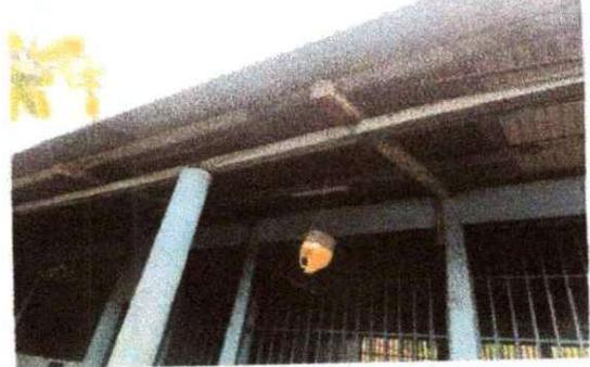
**Foto 8: SE OBSERVA QUE LAS COSTANERAS SE ENCUENTRAN EN MAL ESTADO , ES IMPORTANTE DARLE MANTENIMIENTO DE CARÁCTER URGENTE.**
