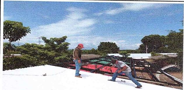
Foto 2. Se observa el modulo de aulas que necesita sustitución lámina y mantenimiento a estructura portante de metal
