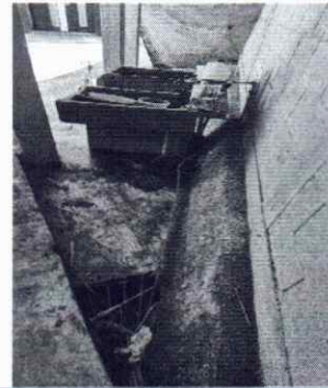
Foto 4: Se observa que se necesita la colocacion de tuberia para sacar el agua al drenaje
