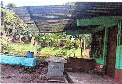
Foto 5: Se observa lámina y estructura de metal instalada.
