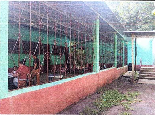
Foto 9: Se observa balcon de metal instalado.
