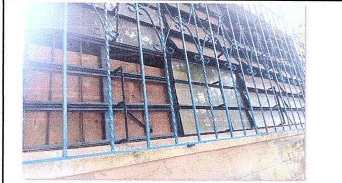
Foto 1: Se observa balcón de metal instalado.
