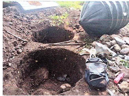
Foto 10: Se observa la instalación de dos biodigestores y pozo de absorción.
