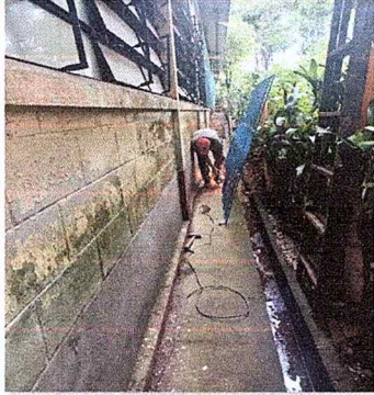
Foto 1: Se observa la colocación del balcón de metal.
