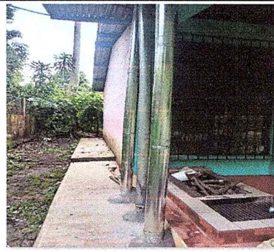
Foto 6: Se observa la sustitución de la chimenea.
