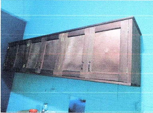
Foto 7: Se observa la colocación de los gabinetes para mejoras de la cocina.
