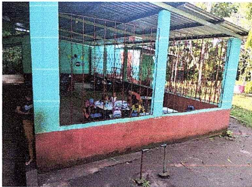
Foto 9: Se observa sustitución de la malla por balcon de metal.
