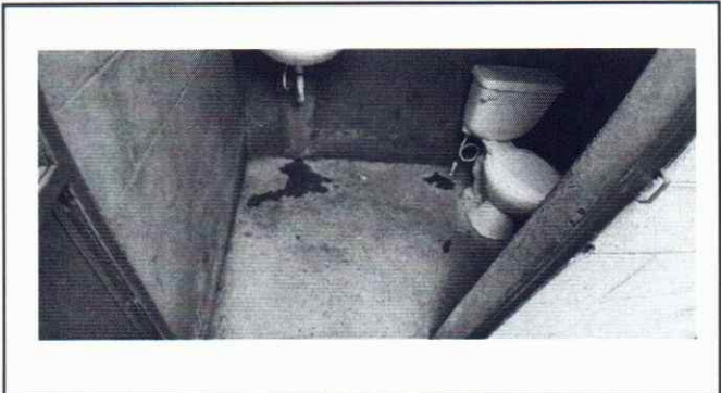
Foto 8: Se observa la necesidad de la colocacion de piso ceramico, azulejo y la sustitucion de accesorios en el lavamanos
