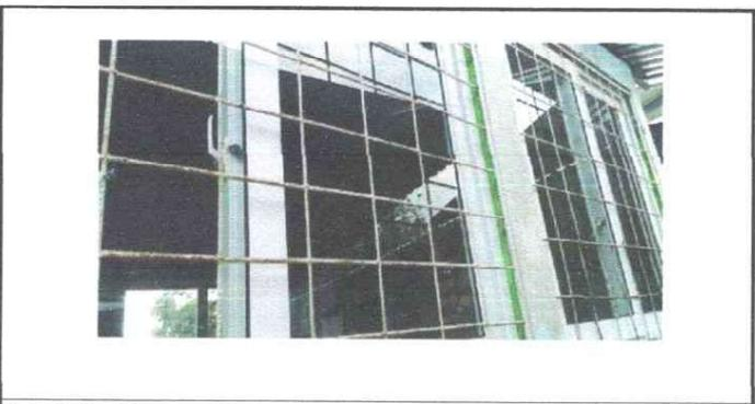
Foto 5: Se observa que se realizó la Instalación de las ventanas pvc.
