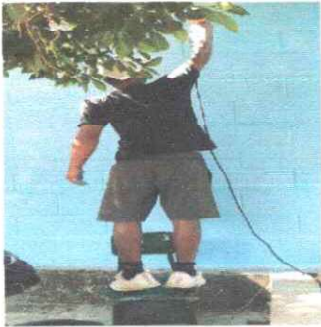
Foto 15: Se procede a pintar el muro perimetral.
