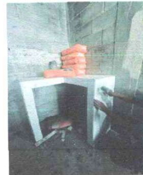
Foto 10: Se procede a colocar piso de azulejo en los muebles.
