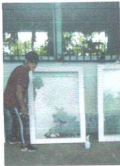
Foto 5: Se procede a colocar las ventanas de pvc.
