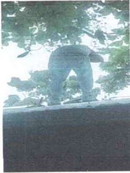
Foto 1: Se procede a realizar la sustitución de las láminas.
