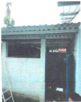
Foto 3: Se procede a realizar la sustitución de los balcones.
