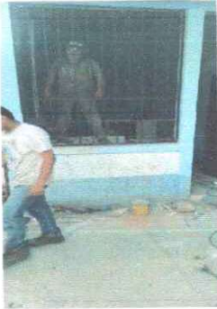
Foto 7: Se procede a resanar la pared de la cocina.
