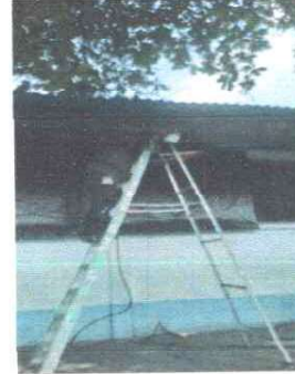
Foto 2: Se procede a brindarle mantenimiento a la estructura.
