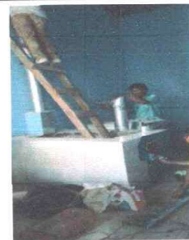
Foto 12: Se procede a colocar la chimenea.
