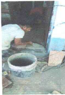
Foto 9: Se procede a colocar el piso ceramico.
