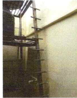
Foto 14: Preparando pared para repello en patio agua potable y cocina
