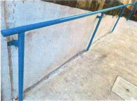
Foto 7: trabajando en baranda
