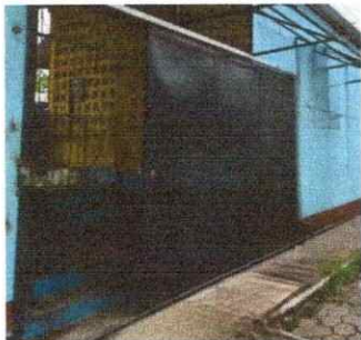
Foto 1: Trabajo del portón de ingreso
