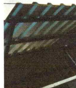
Foto 2: Trabajando en techo del area de ingreso
