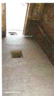
Foto 5: trabajando en caja a mitad de rampa
