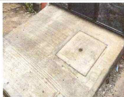
Foto 4: Trabajando en rampa final rampa
