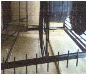
Foto 15: Trabajando en puerta de pozo
