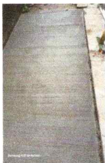
Foto 3: Trabajando en rampa egreso
