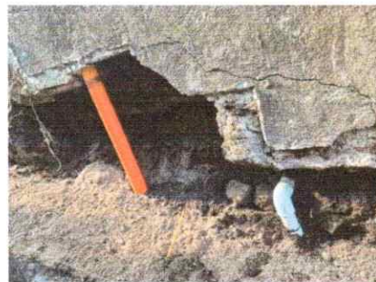
Foto 6: trabajando en socavamiento
