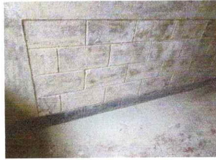
Foto 14: Preparando pared para repello en patio agua potable y cocina
