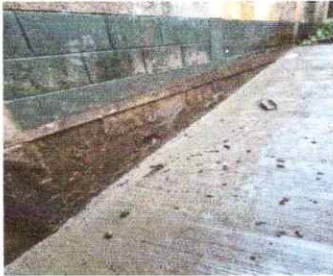
Foto 7: trabajando en baranda
