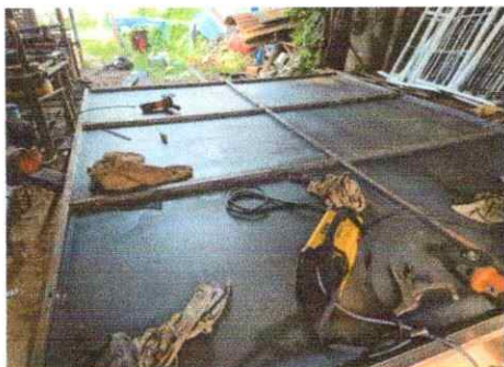
Foto 1: Trabajo del portón de ingreso
