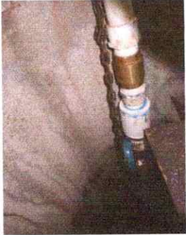
Foto 13: Trabajando en tubería de agua potable y cheque
