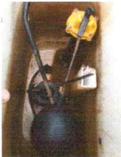
Foto 9: Cambiando accesorios de los baños
