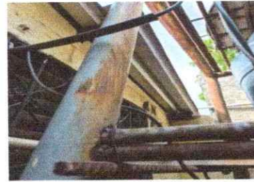
Foto 16: Trabajando en estructura de pozo
