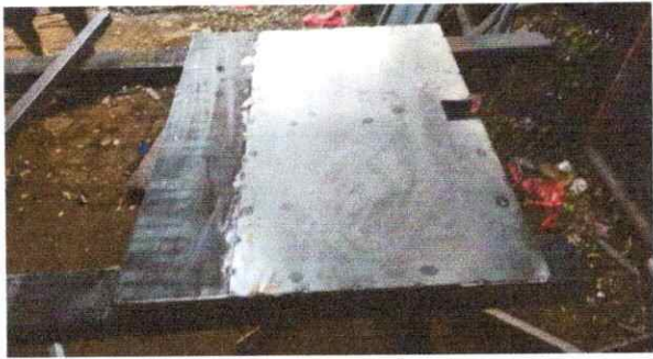
Foto 15: Trabajando en puerta de pozo
