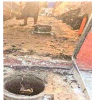
Foto 4: Trabajando en rampa final rampa
