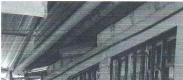
Foto 11: se observa que es necesario el cambio de canal de agua ya que se encuentran en mal estado
