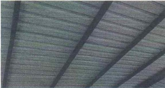
Foto 3: Se observa que las costaneras de los salones se estan deteriorando por lo cual requiere un mantenimiento
