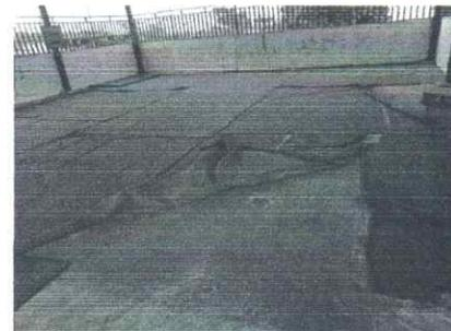
Foto 12: se observa que la losa donde los niños se ejercitan requiere una reparación urgente
