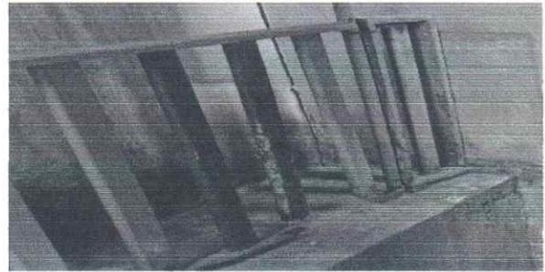
Foto 4: Se observa el gran deterioro de la baranda por lo cual se deben cambiar
