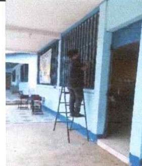
Foto 4: se observa el mantenimiento que se realiza a los balcones de los diferentes salones para evitar el deterioro total de los mismos
