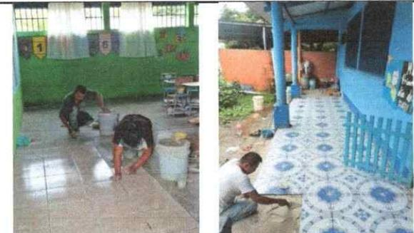
Foto 3: se observa el trabajo que se realiza de pegado de piso ceramico a 2 aulas y piso antideslizante en los modulos 1 y 2 para brindar una mejor recreacion a los estudiantes
