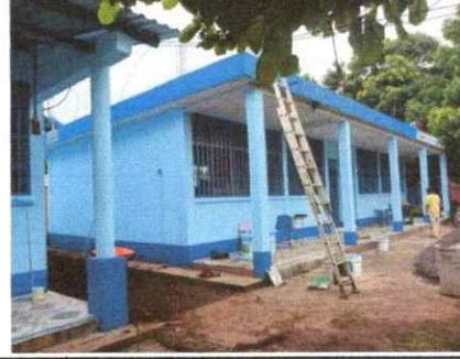
Foto 2: se puede observar el resane y aplicación de la nueva pintura de látex que se realiza en las paredes de los salones
