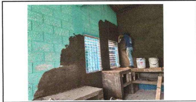
Foto 6: Se procede a repellar las paredes.
