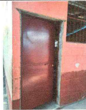
Foto 4: Se observa la sustitución de la puerta.
