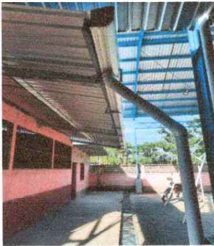
Foto 3: Se observa la que se colocó los canales y bajadas de agua.
