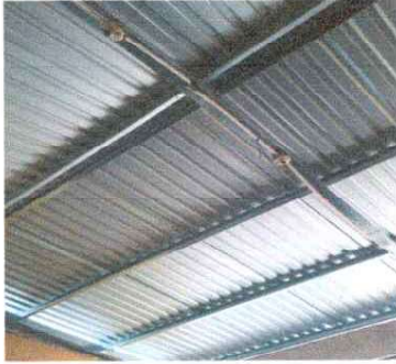
Foto 1: Observa la sustitución de la lámina.
