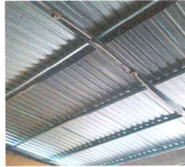
Foto 2: Se observa que se realizó la sustitución de la estructura.
