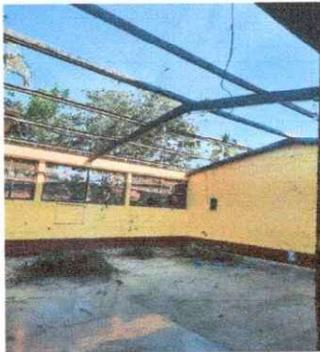
Foto 1: Se procede a quitar la lamina en mal estado para realizar la sustitución.
