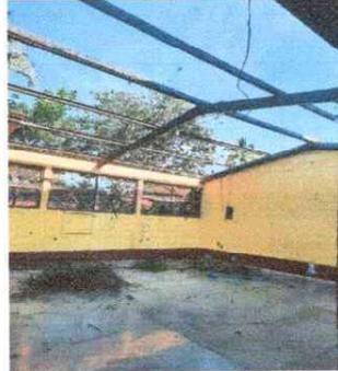
Foto 2: Se procede a quitar la estructura de soporte de madera para sustituirla por metal.
