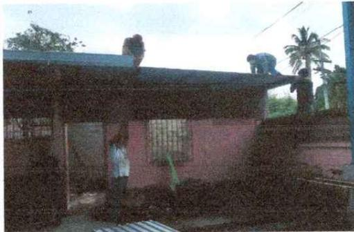
Foto 3: Se procede a colocar los canales para la bajada de agua.
