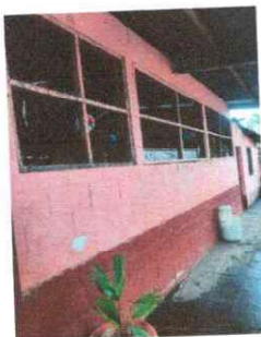
Foto 5: se observa que la malla se encuentra en malas condiciones por lo que requiere balcones
