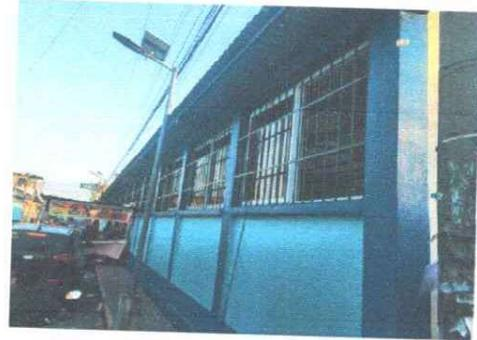
Foto 2: Se observa que se realizó la instalación de las ventanas PVC.
