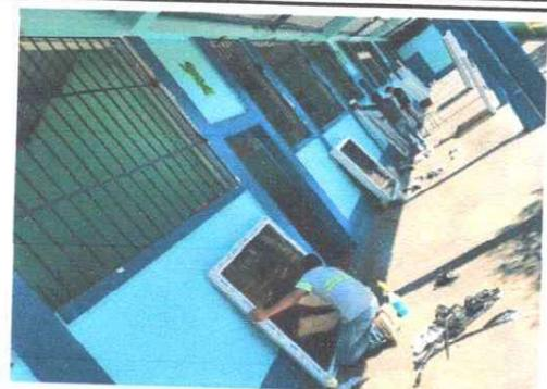
Foto 2: Se procede a realizar la instalación de las ventanas PVC
