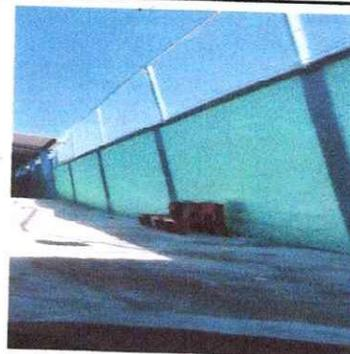
Foto 2: Se observa que se realizo el resane en la pared.
