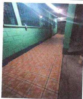
Foto 5: Se observa que se coloco el piso antideslizante
