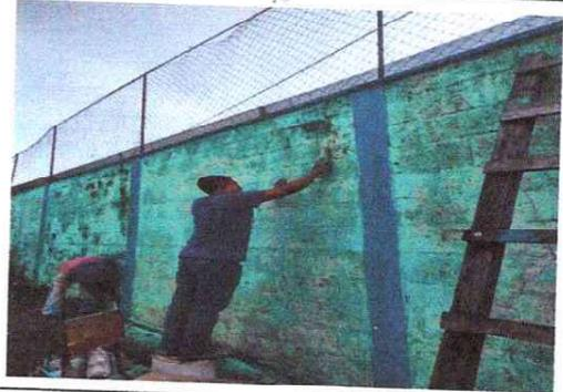
Foto 2: Se procede a realizar el raspado de la pintura en mal estado.
