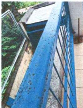
Foto 3: Las barandas demuestran deterioro por estar expuestas a la interperie y por seguridad es necesario dar mantenimiento.
