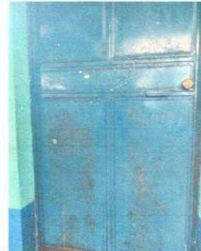
Foto 4: Puertas de aulas con presencia de oxido, se requiere dar mantenimiento.
