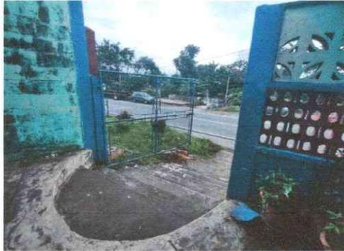
Foto 1: Se observa que el porton principal es de malla, por temas de seguridad es necesario un porton de lámina.
