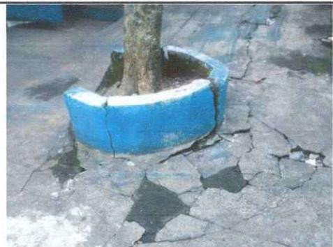
Foto 6: Concreto del patio deteriorado, riesgo de caída de niños, se necesita realizar el cambio de todo el concreto del patio.
