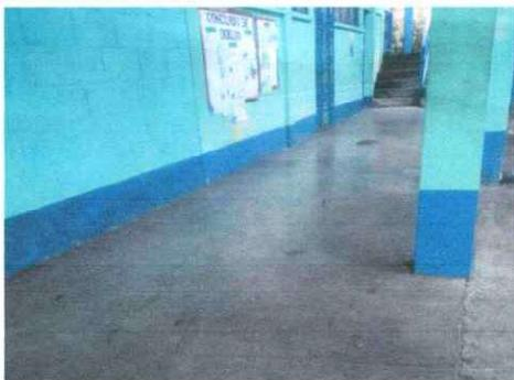
Foto 5: Piso de cemento liso en pasillos, representa peligro de caída de niños en temporadas de lluvia, se requiere piso antideslizante.
