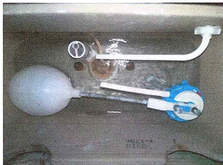
Foto 3: se realizo el el cambio de los accesorios de los baños
