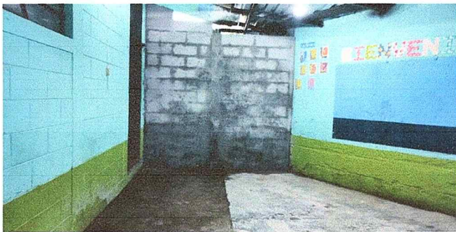
Foto 5: se realizo la sustitución del muro.
