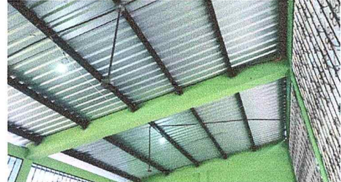
Foto 2: se realizo el cambio de la estructura
