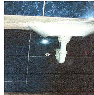
Foto 4: se realizo el cambio de accesorios de los lavamanos
