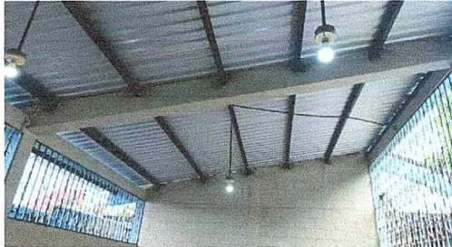
Foto 1: se realizo el cambio de techo.
