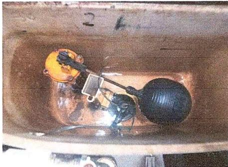
Foto 3: se empieza a cambiar los accesorios de los sanitarios
