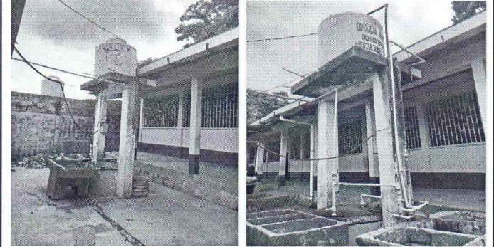
Foto 6: El depósito de agua es muy pequeño para el abastecimiento de agua en la escuela, es necesario sustituirlo por un depósito de 2,500 lts.
