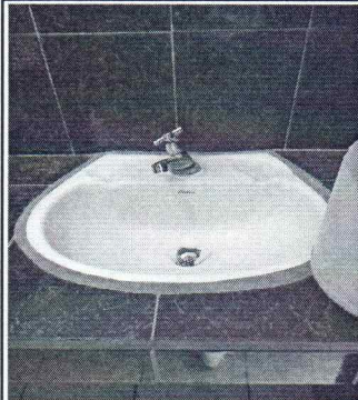
Foto 4: Se observa que los accesorios de los lavamanos presentan daños, es necesario su reparación para utilizarlos.
