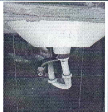
Foto 4: Se observa que los accesorios de los lavamanos presentan daños, es necesario su reparación para utilizarlos.
