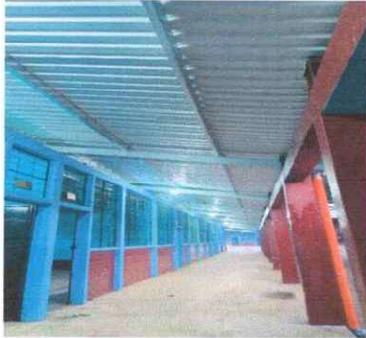
Foto 1: Se realizó el cambio de la estructura de soporte del módulos de aulas.
