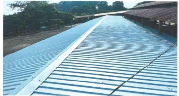
Foto 2: Se realizó el cambio de las láminas del módulo de aulas.
