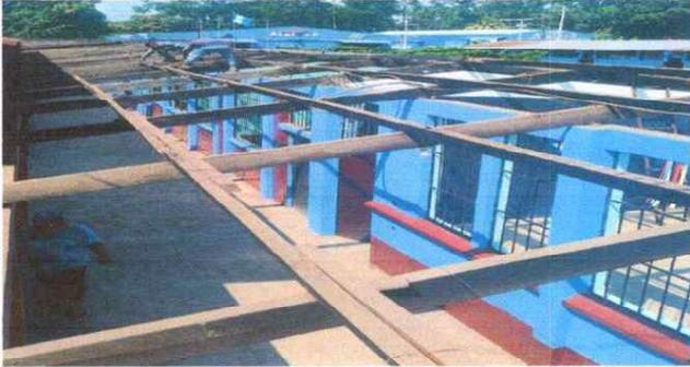
Foto 1: Se procede a quitar la estructura de soporte para su sustitución en el módulo del aulas.
