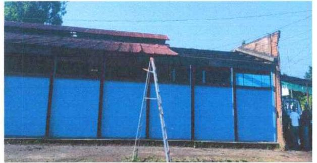
Foto 2: Se procede a quitar las laminas para su sustitución en el módulo de aulas.
