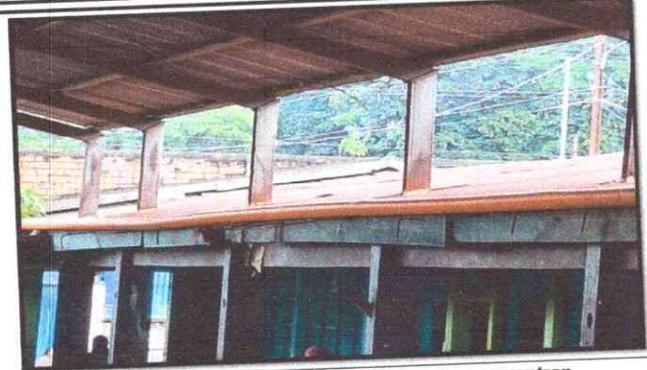
Foto 2: se observa el techado del modulo que ya se encuentran deterioradas por lo cual se requiere sustitucion
