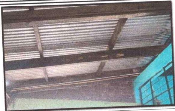
Foto 1: se observa que la estructura de soporte se encuentran en malas condiciones por lo cual se necesita sustituirlo
