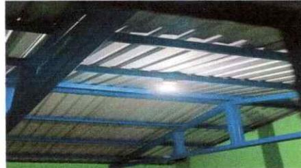
Foto 2: Se realizó la sustitución de la estructura de soporte.
