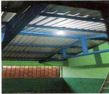
Foto 1: Se realizó la sustitución de la lámina.
