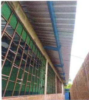
Foto 3: Al realizarse el cambio de las láminas se procede a colocar los canales para el agua.
