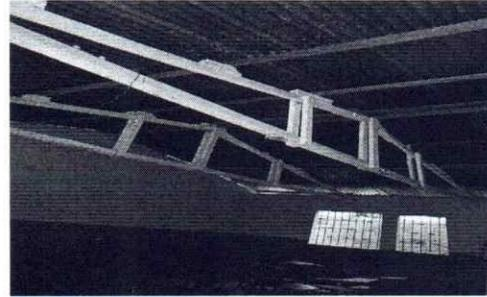
Foto 2: Se observa que el soporte de la lámina ya está a punto de colapsar
