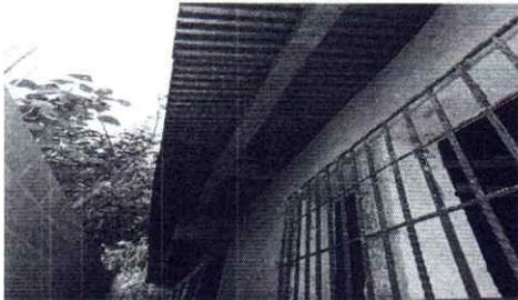
Foto 3: Se observa que no existe el canal de agua por lo que es necesario instalar una
